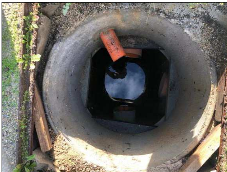
Figura 3.2/III: Vista interna del pozzetto scolmatore
