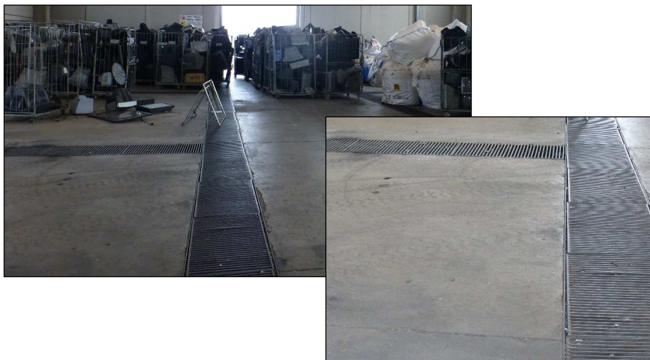
Figura 3.2/IX: Canalette a pavimento.
