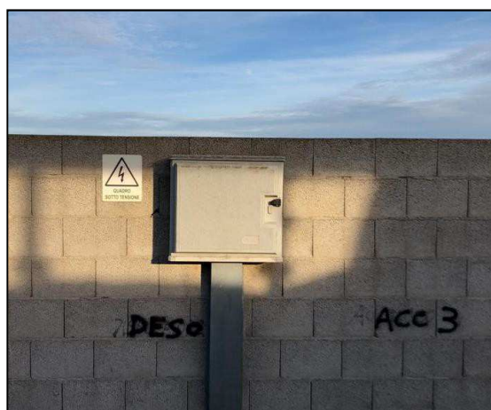
Figura 3.2/IV: Vista della centralina di controllo dell'impianto prima pioggia
